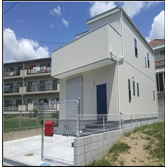
シンプルな倉庫風な外観
